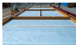
試験施工を実施した型枠
