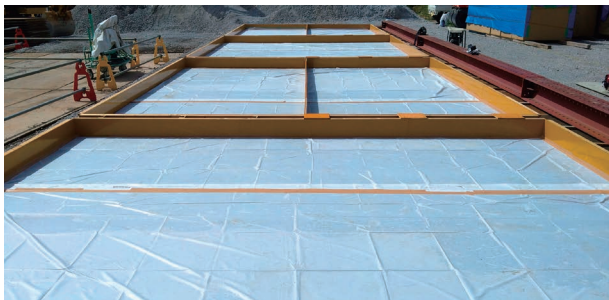
写真4 型枠の設置状況
