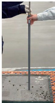
写真6 N式貫入試験の実施状況
