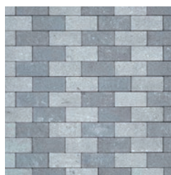
(b) 敷設状況
