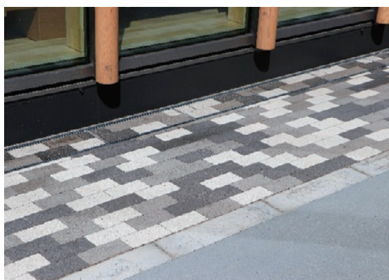
施工後のバイオ炭ILブロック舗装
