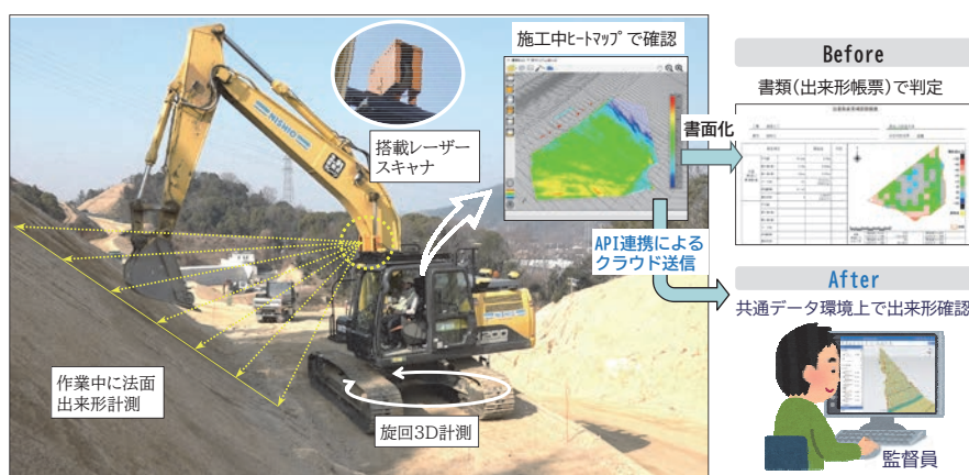
図 重機搭載レーザー計測と共通データ環境のAPI連携
