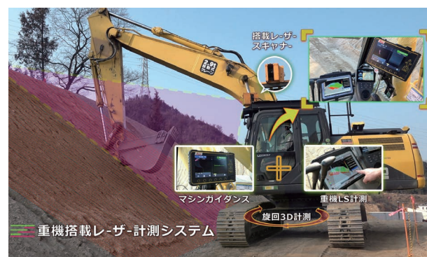
図3 STEP1 施工しながら出来形管理
