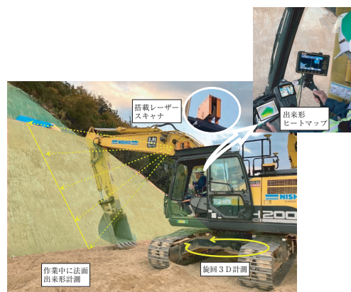
図1 重機搭載レーザー計測システム
