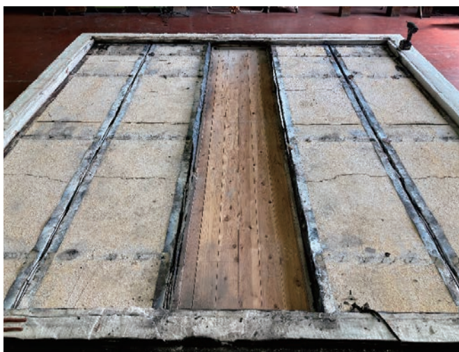
耐火試験後のカンタイパネル
