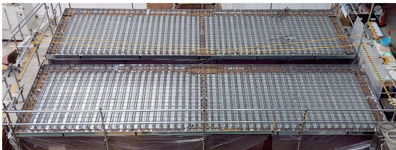
写真1 実大試験体のコンクリート打込み前状況
