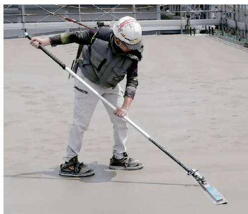
写真2 実スラブでのフレスノ掛けの状況
