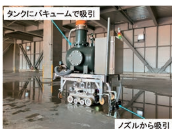
ロボットによる水替え作業の様子
