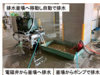
ロボットによる水替え作業の様子
