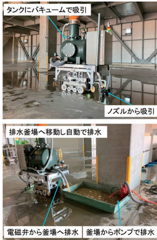
図 11 水替え作業、排水釜場への排水の様子
