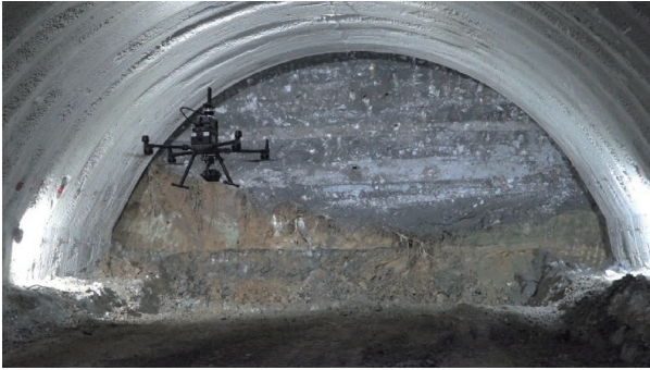
写真2 切羽の遠隔（無人）点検状況
