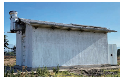
プロトタイプ貯蔵庫外観
