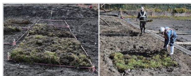
写真2 表土の仮置き(左)・表土復元(右)
