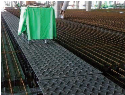
写真 1 現場 B での水平搬送の状況
