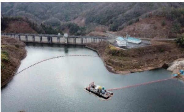
写真1 ダム湖における試験施工
