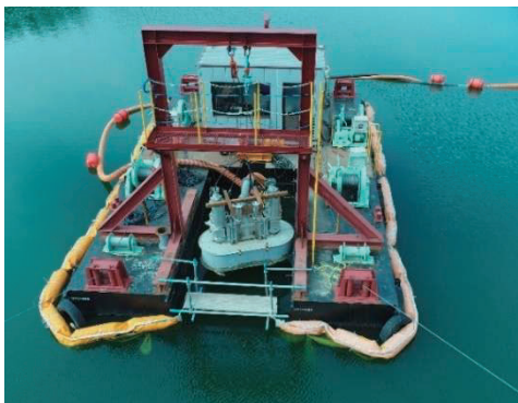
写真2 作業台船全景
