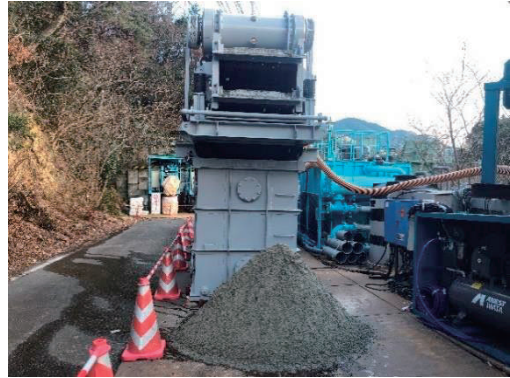
写真5 陸上ヤード 砂回収状況
