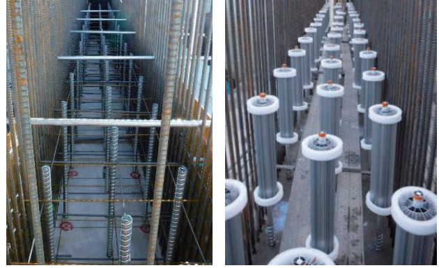
写真1 シース管設置状況
