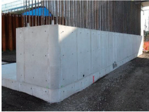
写真3 堅壁1リフト構築状況
