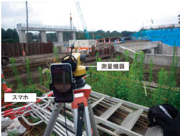
図7 測量機器への取り付け
