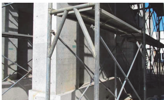
写真1 実大模擬壁試験体 (H)
