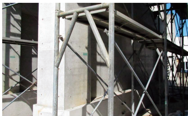
写真1 実大模擬壁試験体 (H)
