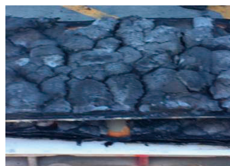
写真3 シリーズ1の燃焼後の芯材(天井面)
