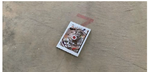
図8 地墨交点へのマーカー設置状況
