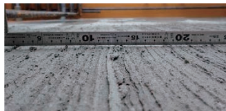
写真1 打継部の刷毛引き後の状況
