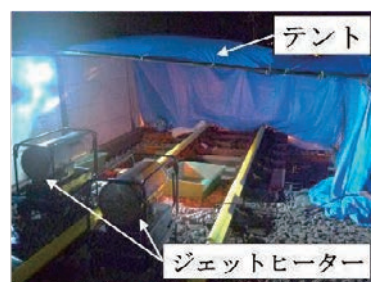
写真5 打込み箇所の対策例
