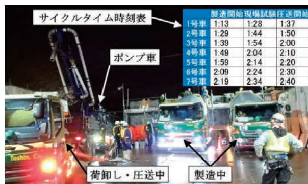
写真6 コンクリートの製造および圧送状況
