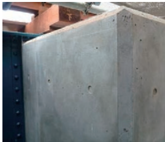
写真4 コンクリートの出来形
