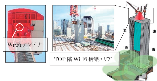
図 32 TOP 階 Wi-Fi 構築エリアとアンテナ設置写真
