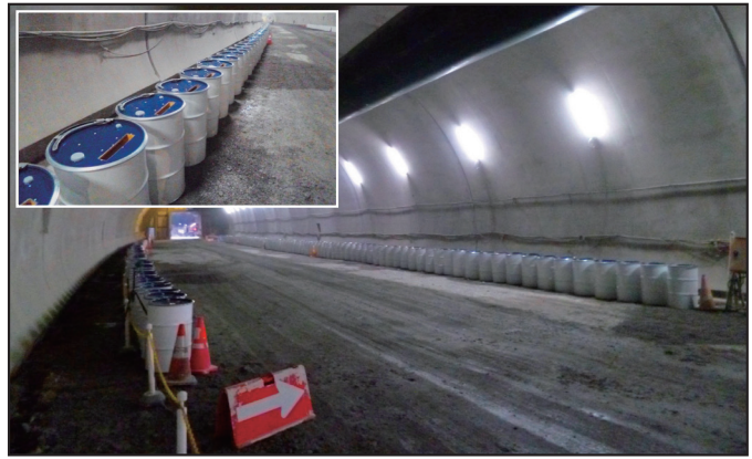
坑内への設置状況 (200 体)
