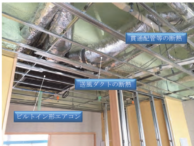
写真1 ロフト内状況
