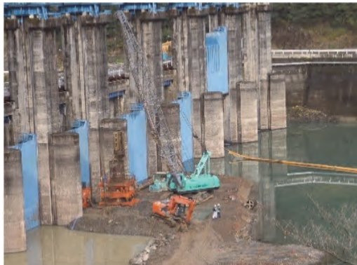
写真1 掘削状況(全景)
