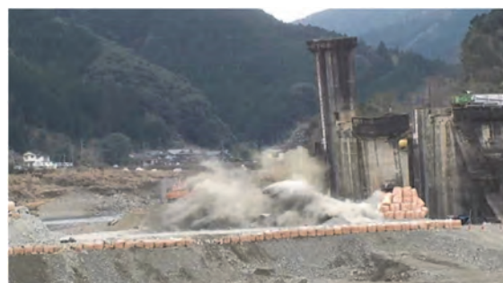
写真 3 P2 倒壊発破 発破の瞬間
