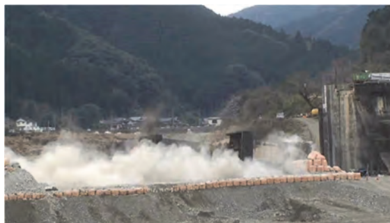
写真 4 P2 倒壊発破 倒壊の瞬間
