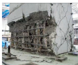
補強試験体 最終破壊状況
