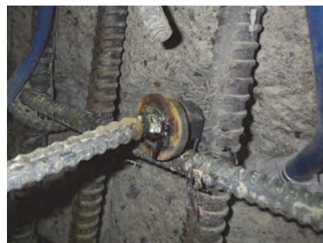
(2) せん断補強鉄筋の補修
