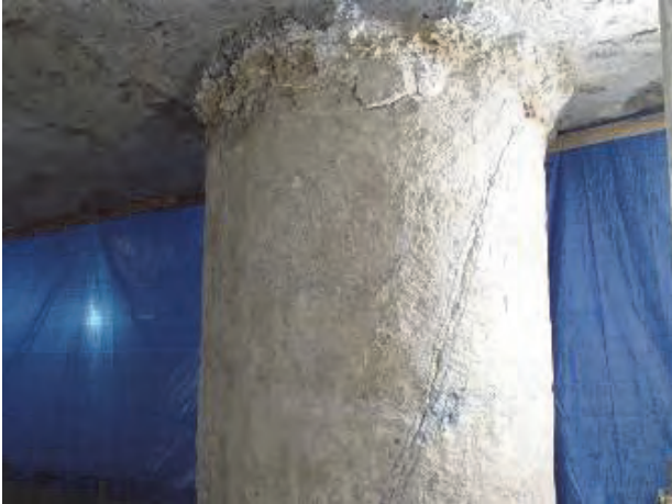
写真 3 せん断破壊(C-4)
