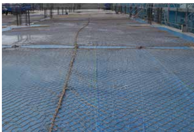
スラブコンクリートの養生状況
