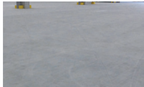
写真1 塗布型収縮低減剤を塗布したスラブ表面
