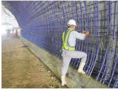
写真5 ケーブル設置状況(側壁部)
