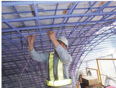
写真6 ケーブル設置状況(天端部)
