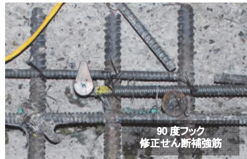
(1) せん断補強筋の修復
