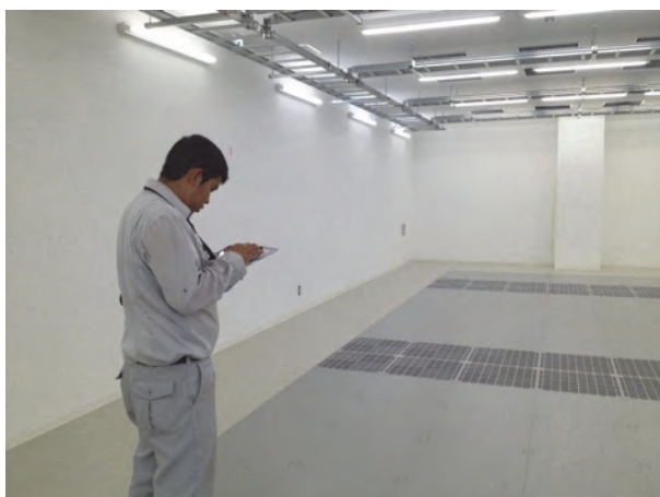
図12 現場利用状況
