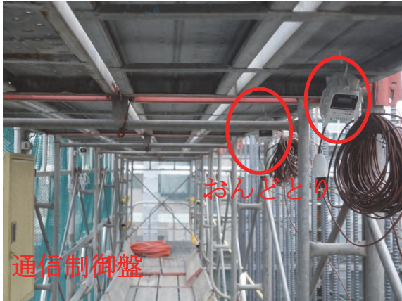
写真6 おんどとり、通信制御盤設置状況
