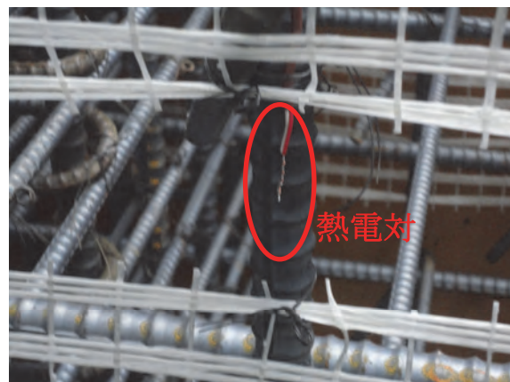
写真5 熱電対設置状況(表面)
