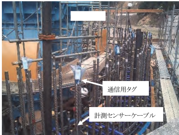
写真2 計測機器の設置状況
