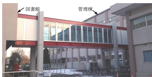
写真 1 渡り廊下の外観
