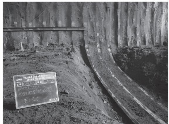
図 11 吹付けインバートによる早期閉合状況
