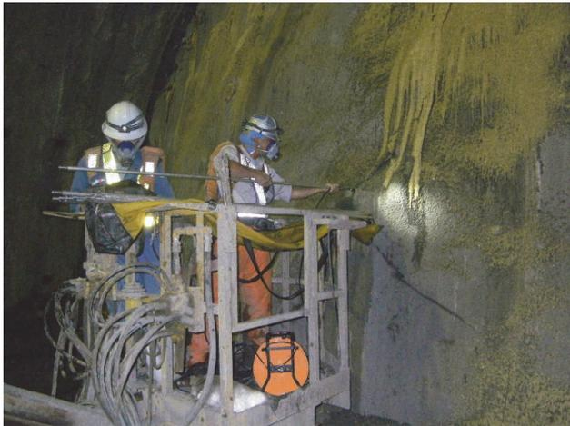
図 9 切羽前方変位計測状況
