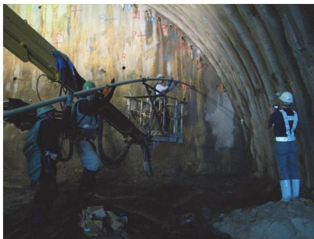
図5 人力によるCG管の挿入状況
