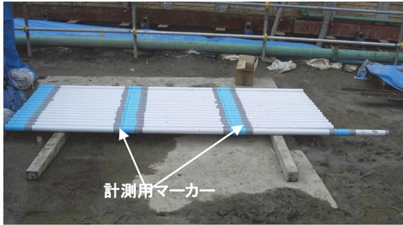
図 8 埋設する計測管
