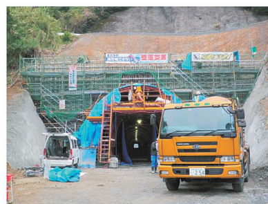
坑門工の施工状況
