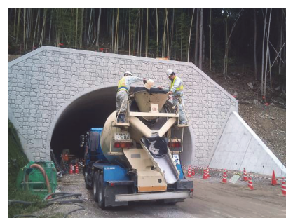
写真 3 混和剤の後添加状況
