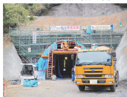
写真 4 坑門工の施工状況
