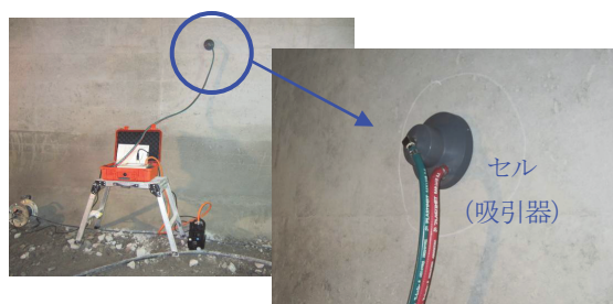
写真 5 透気試験の状況
