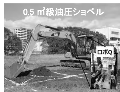
図 11 建機側実験状況
