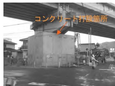
図6 既設橋脚の耐震補強工事への適用例
