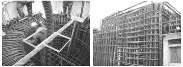
写真 1 高密度配筋の事例
