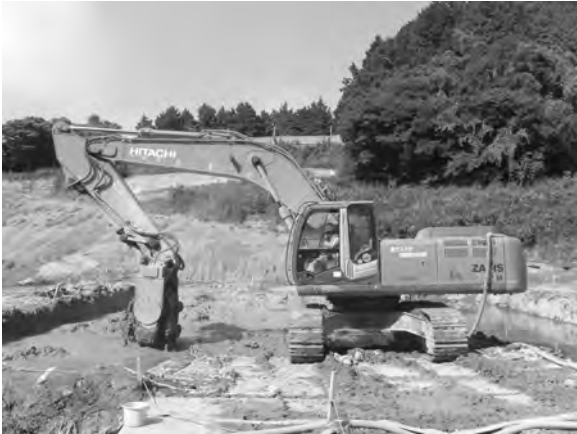
写真4 混合泥土の初期固化状況
