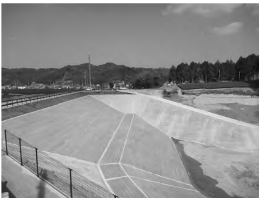
写真 2 改修工事実施後の堤体上流側の状況
