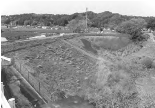
写真 1 改修工事実施前の堤体上流側の状況
