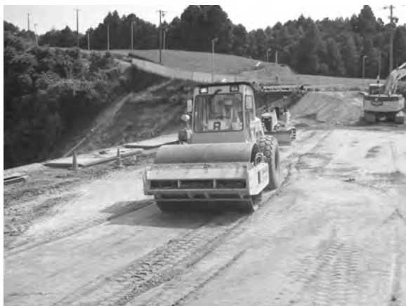
写真6 解砕土の振動ローラによる転圧状況
