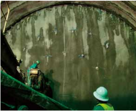
鏡ボルト打設状況
