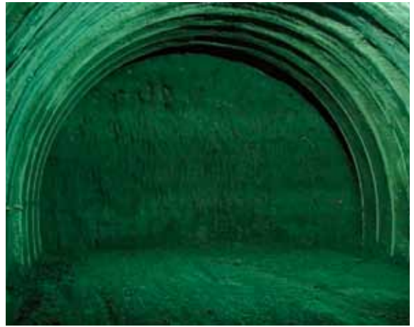
D地山における全断面掘削終了状況
