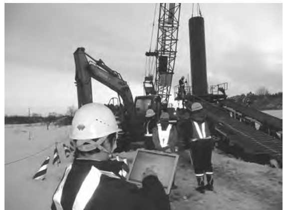
図 12 現場実証実験状況
