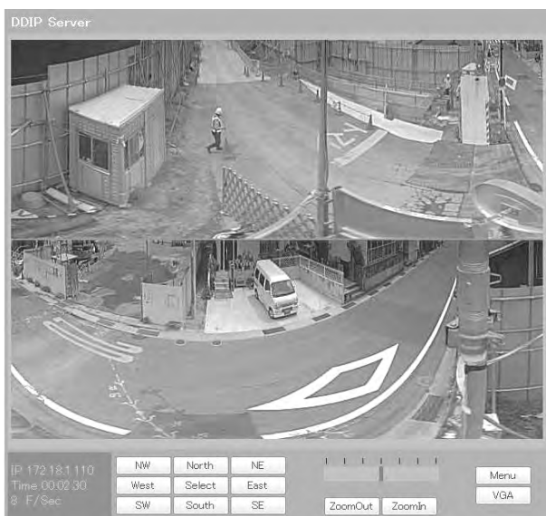
写真9 360度カメラ監視映像
