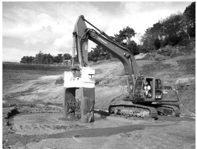
写真2 DAMによる攪拌状況
