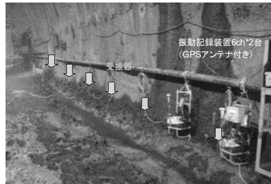
図3 側壁脚部への受振器の設置状況
