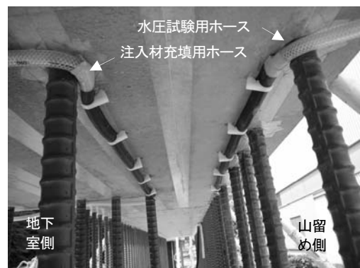
写真1 先行埋設型ホースの取付け(図2のCから)
