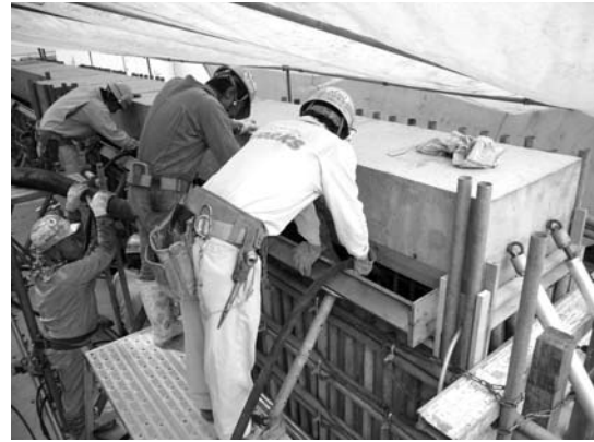
写真2 後打ち部コンクリートの打設状況(外柱・外壁)
