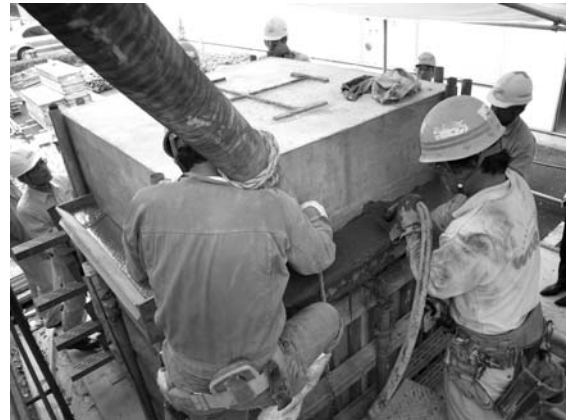
写真 3 後打ち部コンクリートの打設状況(内柱)
