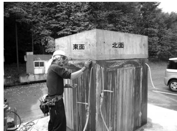
写真 5 一次注入材充填状況例(内柱:北面, 東面)
