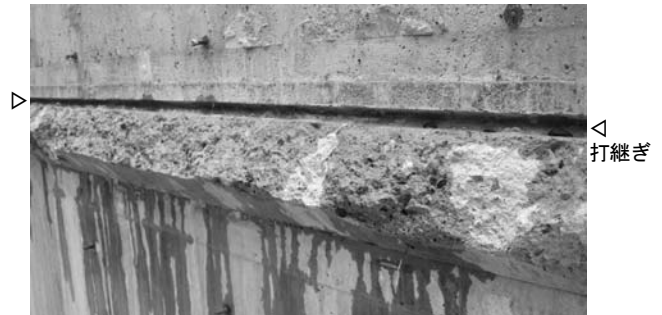
写真 11 水圧試験状況例 (一次注入材充填後 : 0.10MPa)
