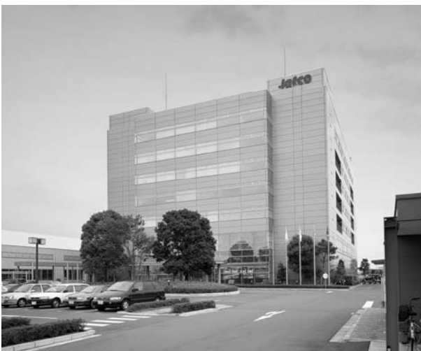
写真1 対象建物外観
