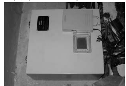
写真2 SMAC-MD 加速度計(1F)
